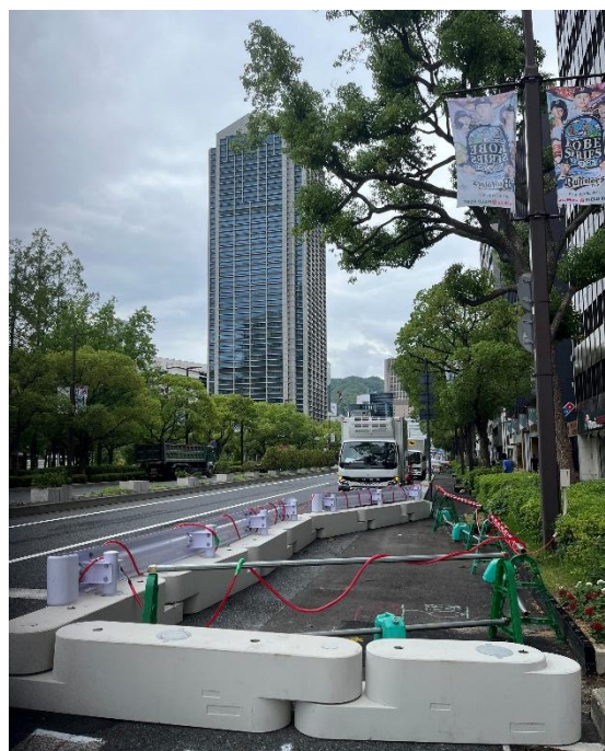
【環境配慮型ブロック設置状況】
