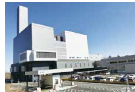
2023年3月、埼玉西部クリーンセンター竣工
